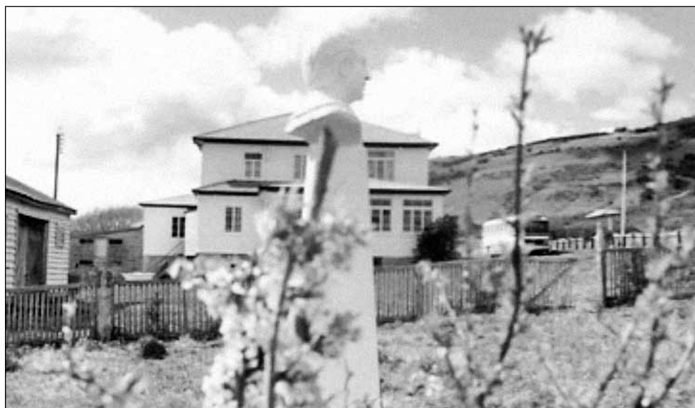
Tercer Hotel Tres Pasos, destruido por un incendio en 1997, galpón que se aprecia a la izquierda es original a la época de Gabriela Mistral.
